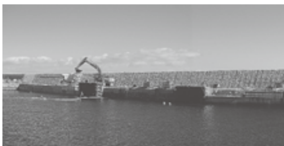
蛇浦漁港整備工事
