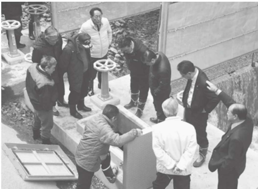
改修が進められている水道施設
