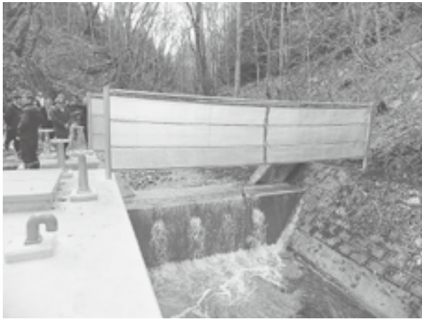
取水口改修後
