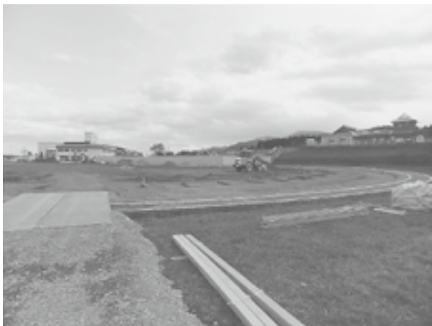
多目的グラウンド整備工事の状況
