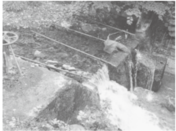
取水口改修前
