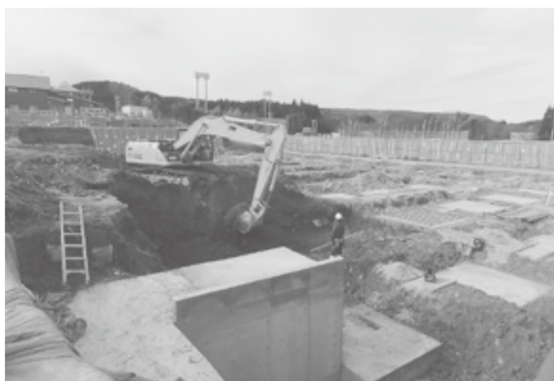
風間浦小学校建設現場
