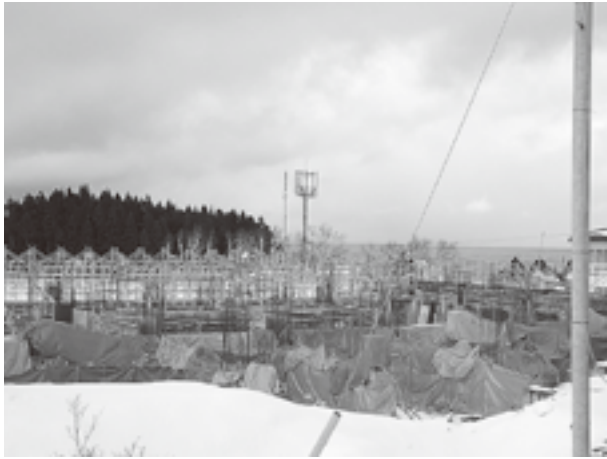
風間浦小学校工事現場
