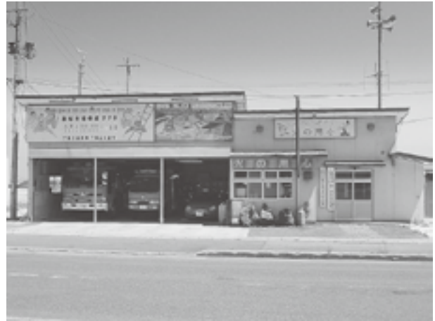
廃止された下風呂分遣所（現：第2分団屯所）
