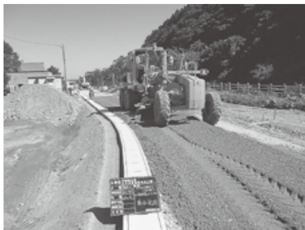
大川目線道路工事
