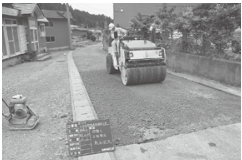
村道補修工事
