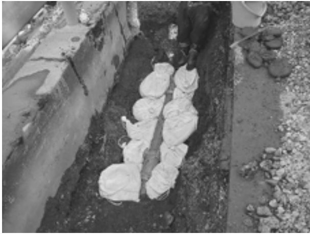
漏水箇所の修復工事
