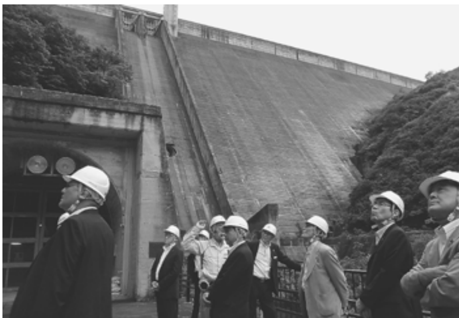
奥只見水力発電所
