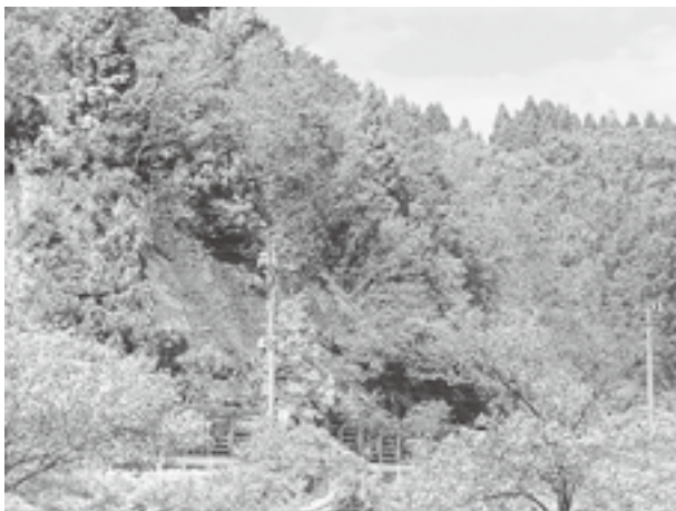
台風10号による土砂崩壊現場（下風呂地区）
