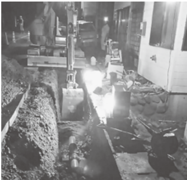
下風呂地区の工事現場
