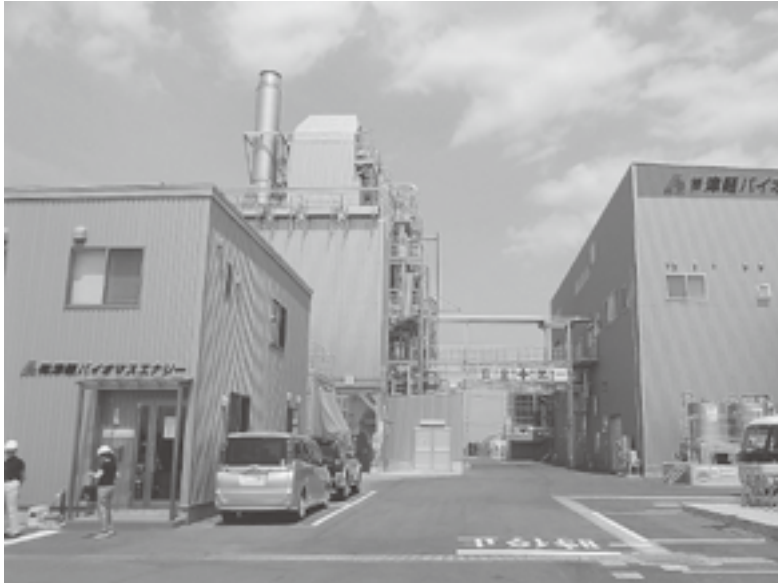
(株)津軽バイオマスエナジー
