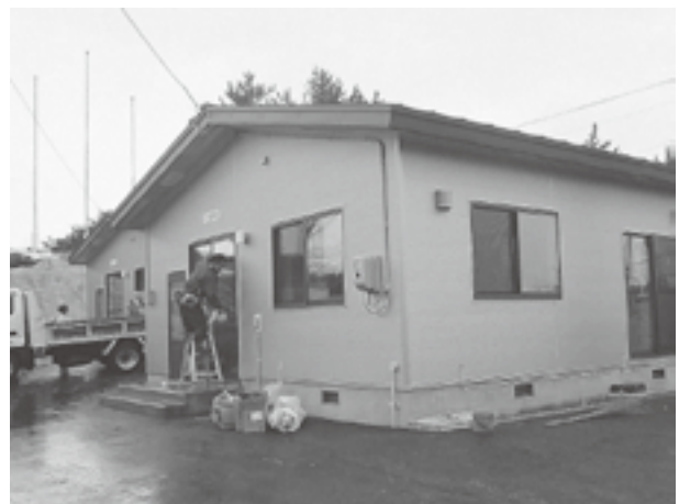
完成間近の新教員住宅
