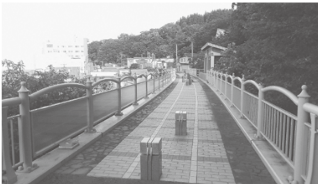
鉄道アーチ橋
