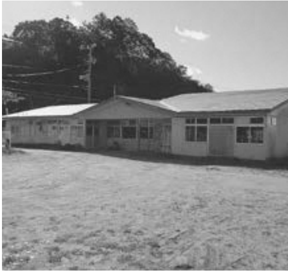
解体する旧下風呂保育所
