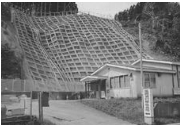
崩落箇所改修工事
