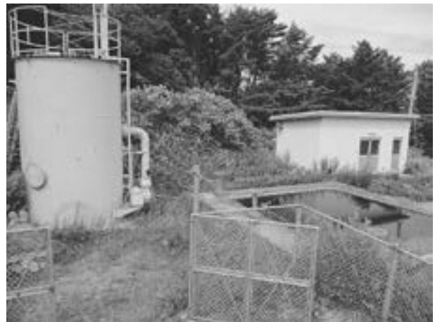
易国間浄水場
