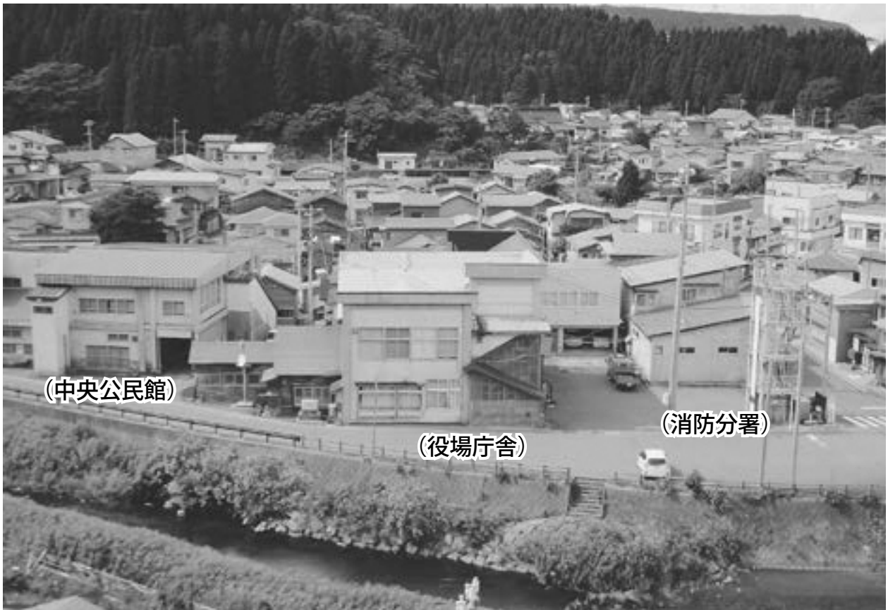
移転予定の役場庁舎・消防分署及び中央公民館
