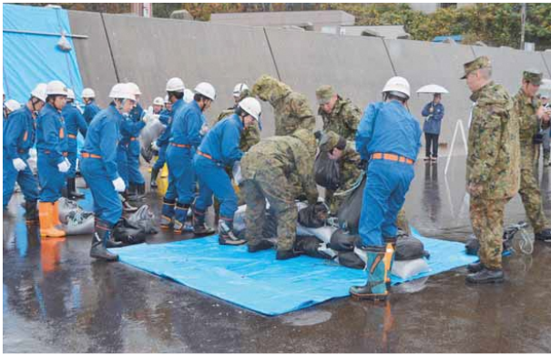
土のう積み工法
