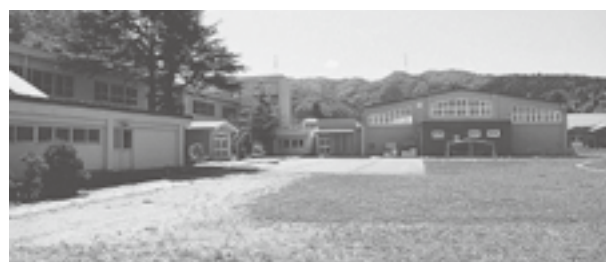
庁舎等建設予定地の旧易国間小学校跡地
