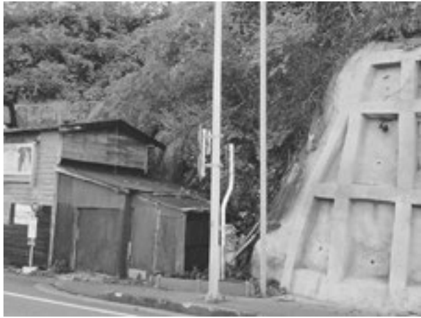
畑尻ノ下地区小規模治山工事
