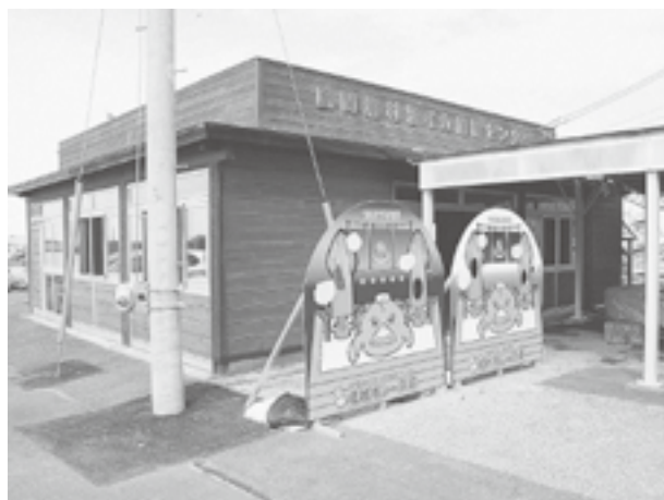
活イカ備蓄センター
