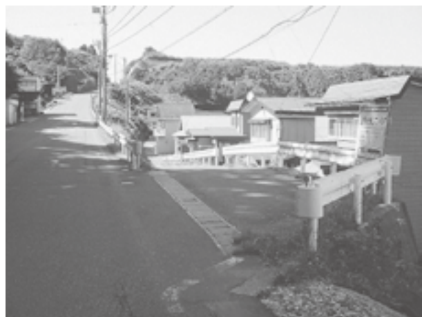
甲本通線改良工事の進入路
