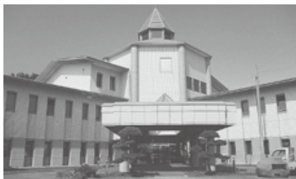
岩崎支所庁舎
