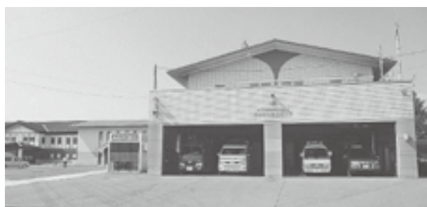
岩崎消防分署
