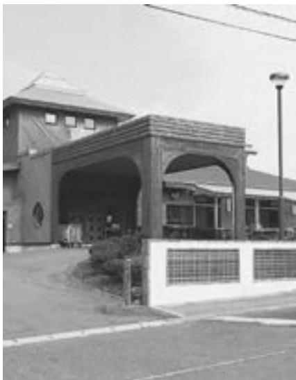
保育料無償化対策を実施している風間浦保育所
