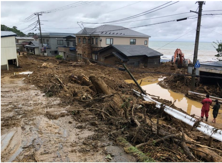
↑ 畑尻ノ下地区 (土砂崩れ)
