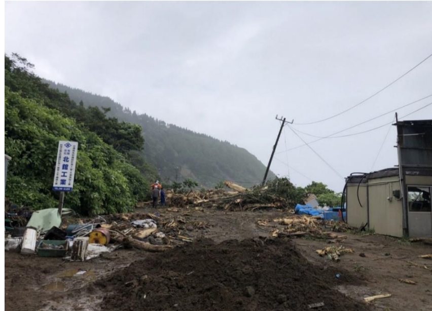
↑ 北館工業前 (土砂崩れ)
