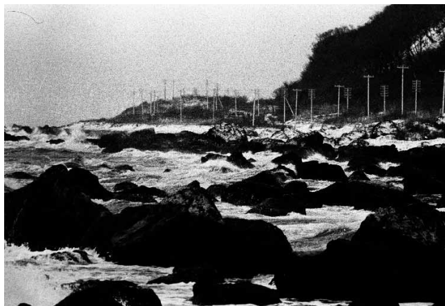
桑畑付近の電柱が林立する道
