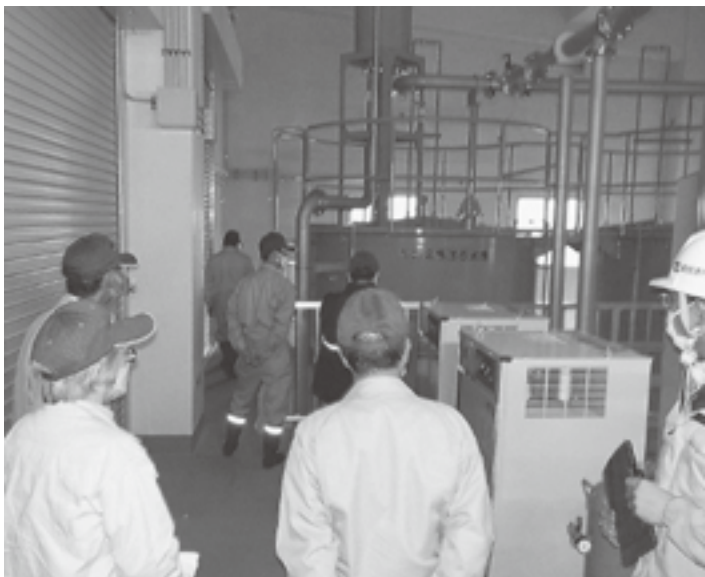
易国間浄水場浄水棟
