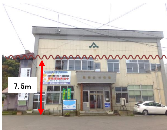
役場庁舎 昭和 11 年建設（築 85 年）
