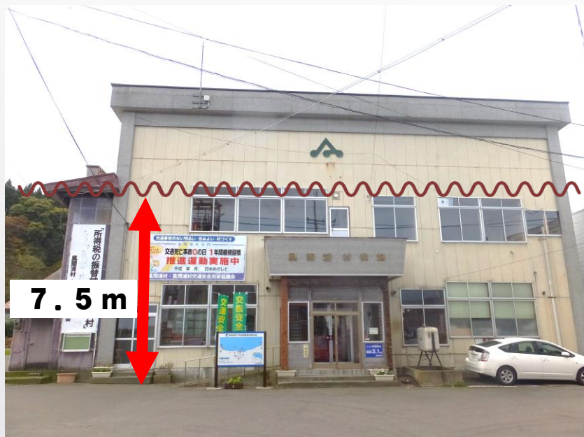
役場庁舎 昭和11年建設(築85年)
