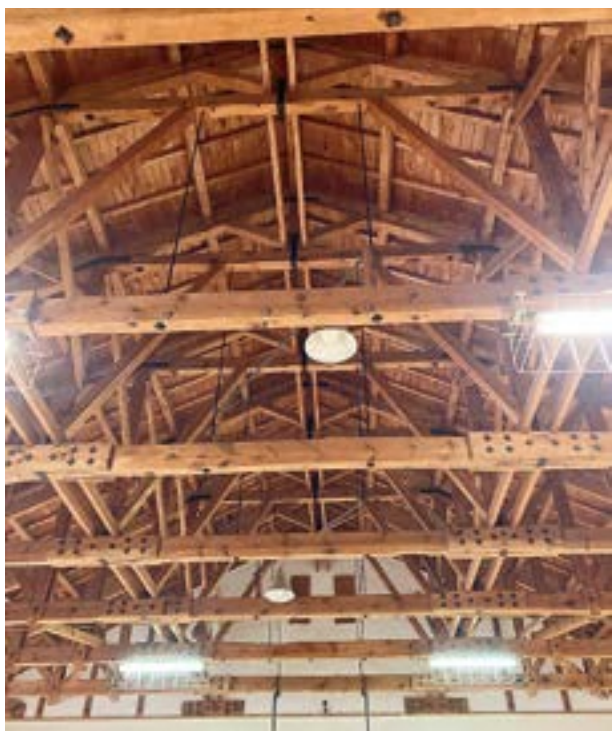
体育館の天井
