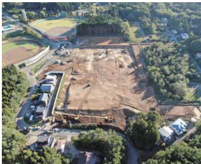
造成工事進捗状況（令和6年9月末）
