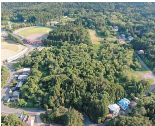
工事施工前（令和6年6月末）
