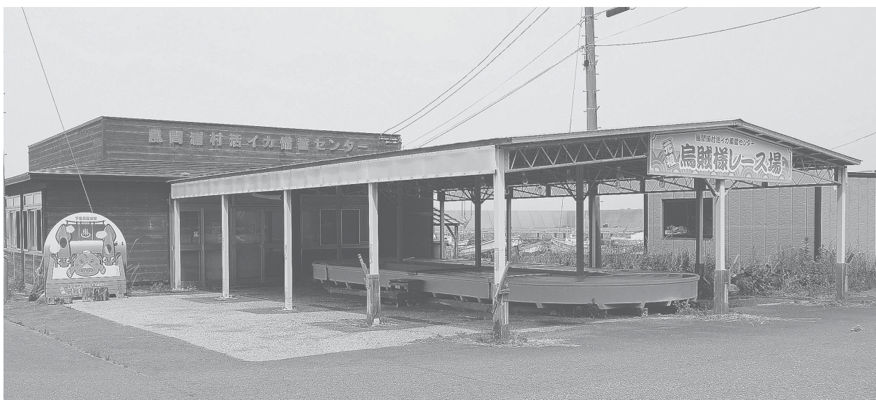
活イカ備蓄センター
