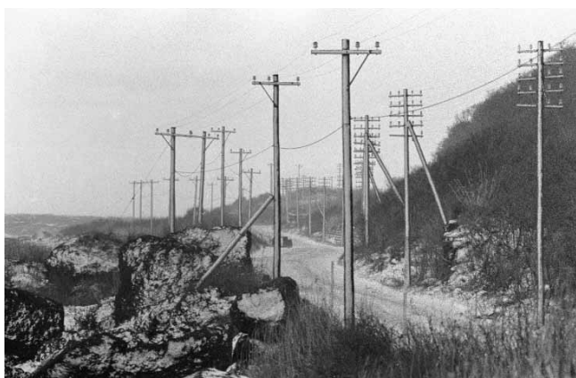
桑畑付近の電柱が林立する道
