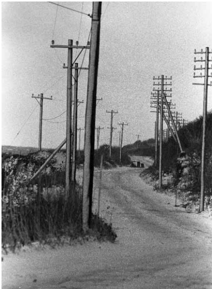
桑畑付近の電柱が林立する道
