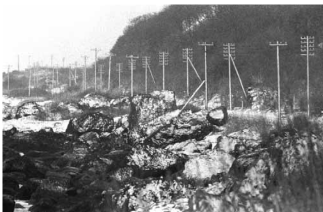
桑畑付近の電柱が林立する道
